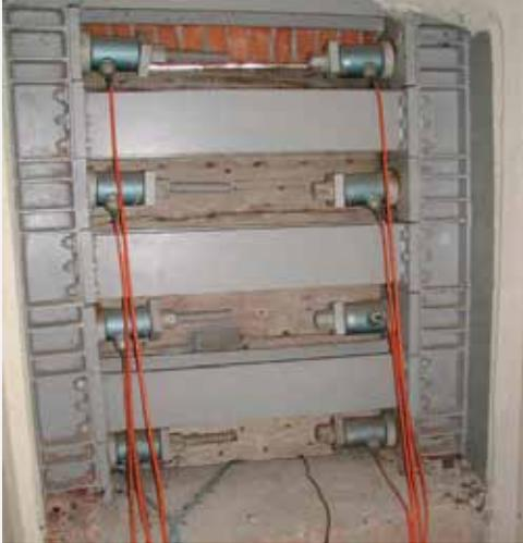
Dettaglio di quattro barre del sistema di cerchiaggio
